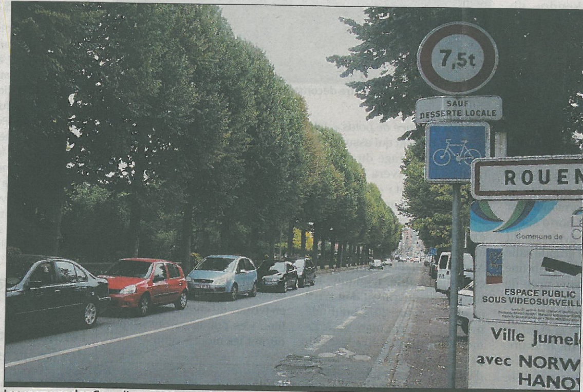
Les avenues des Canadiens et Martyrs-de-la-Résistance sont larges, mais la chaussée est bien abîmée
