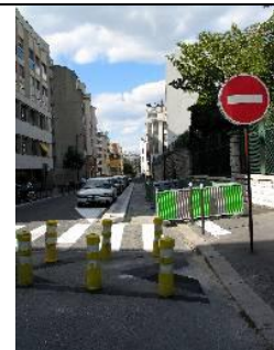
Exemple piste entre trottoir et stationnement (en cours de réalisation, il manque le panneau « sauf cyclistes »)
